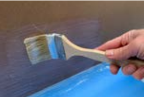
1. FDB CONNECT PRIMER mit Pinsel auftragen
