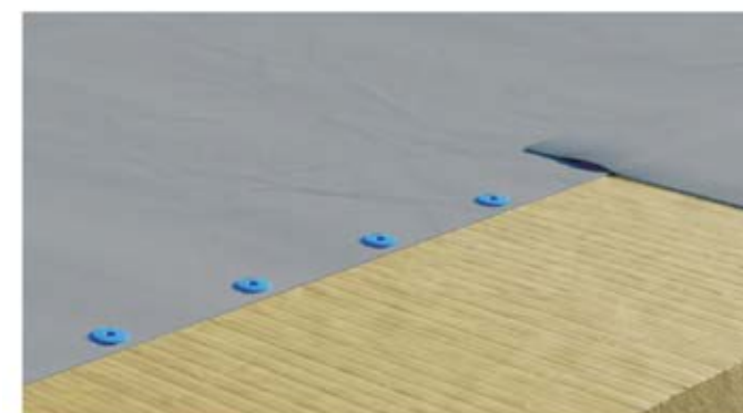
Befestigung von PVC-Dachbahnen und Dämmung auf Betondachkonstruktionen
