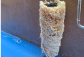
2. FDB CONNECT PRIMER mit geeigneter Walze auftragen
