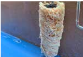
2. FDB CONNECT PRIMER mit geeigneter Walze auftragen
