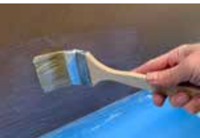
1. FDB CONNECT PRIMER mit Pinsel auftragen
