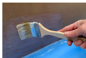
1. FDB CONNECT PRIMER mit Pinsel auftragen
