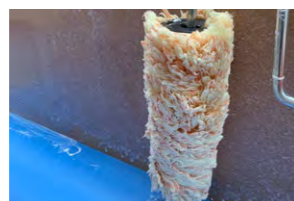
2. FDB CONNECT PRIMER mit geeigneter Walze auftragen
