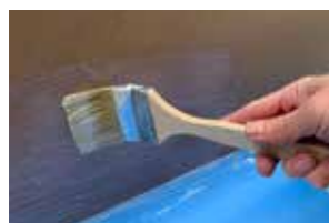
1. FDB CONNECT PRIMER mit Pinsel auftragen
