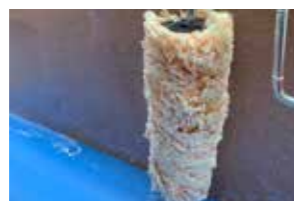
2. FDB CONNECT PRIMER mit geeigneter Walze auftragen
