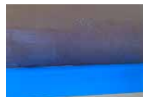
3. Ca. 30 Minuten ablüften bis zum Farbumschlag von weiß zu transparent.
