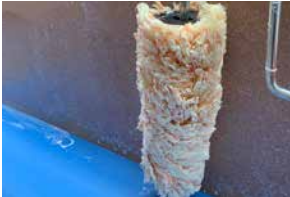
2. FDB CONNECT PRIMER mit geeigneter Walze auftragen
