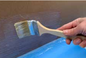
1. FDB CONNECT PRIMER mit Pinsel auftragen
