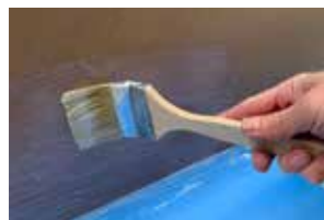
1. FDB CONNECT PRIMER mit Pinsel auftragen
